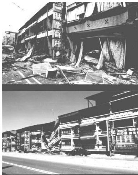
圖 5-1 上圖為埔里南興街商圈地震受損情形 下圖為埔里信義路商圈地震受損情形
