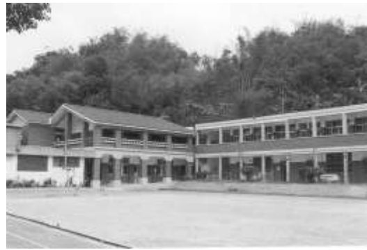
16.周明德先生(儒林補習班)認養台中縣 霧峰鄉坪林國小坪部分校。
