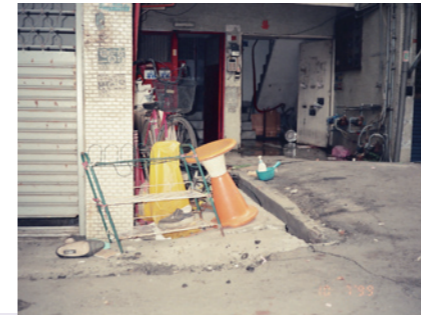
1999年10月災後震損情形
