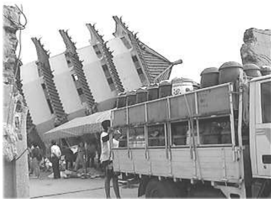
圖 7-28 震毀的民雄鄉納骨塔
