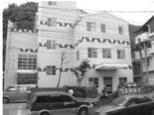
圖 7-11 復建後的信義鄉衛生所 重建會提供
