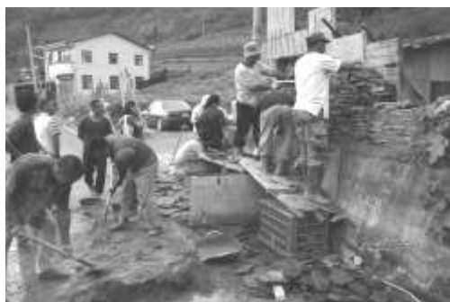
圖 7-45 東埔居民參與石板工程 重建會提供
