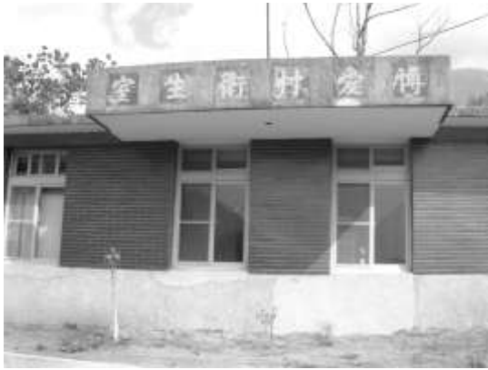
圖 7-12 復建後的和平鄉博愛村衛生室
