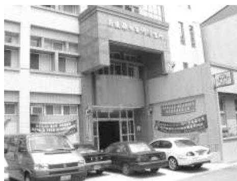
圖 7-9 復建後的中寮鄉衛生所 中寮鄉衛生所提供
