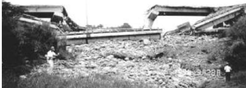
圖 4-93 震後損毀的名竹大橋
