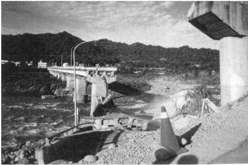
圖 4-70 震後損毀的埤豐橋
