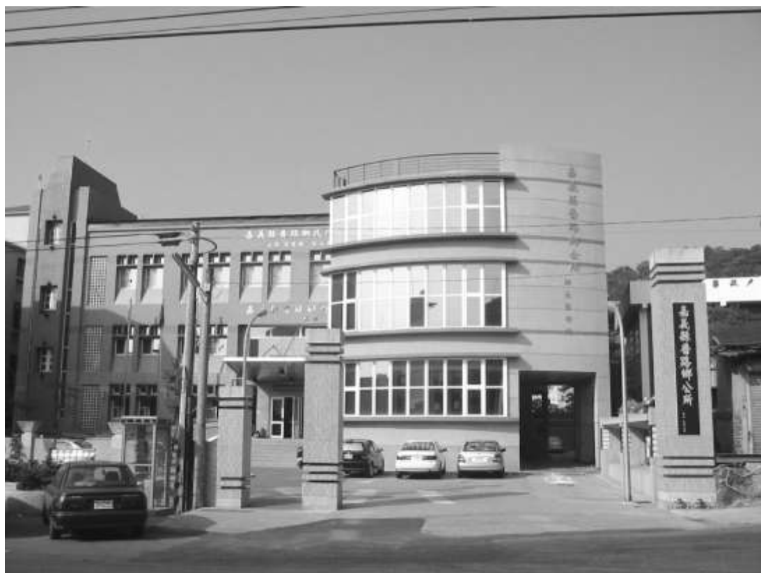
圖 4-8 完工後的番路鄉公所
