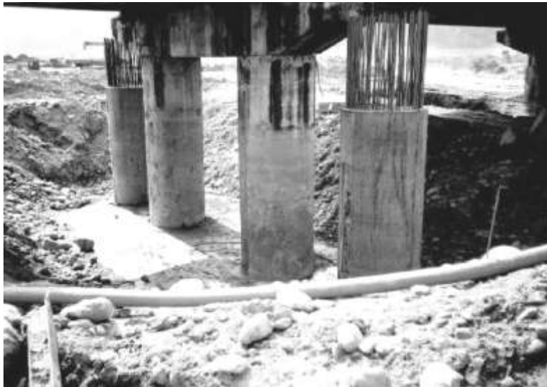
圖 4-87 修復中的炎峰橋
