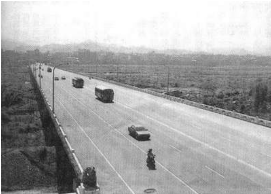
圖 4-75 修復後的東勢大橋 拍攝日期：民國 91 年 3 月 提供者：國家地震工程研究中心
