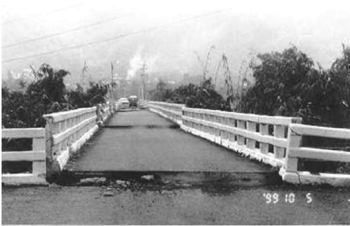
圖 4-95 鯉魚大橋橋面落差情形 拍攝日期：民國 88 年 10 月 5 日 提供者：國家地震工程研究中心
