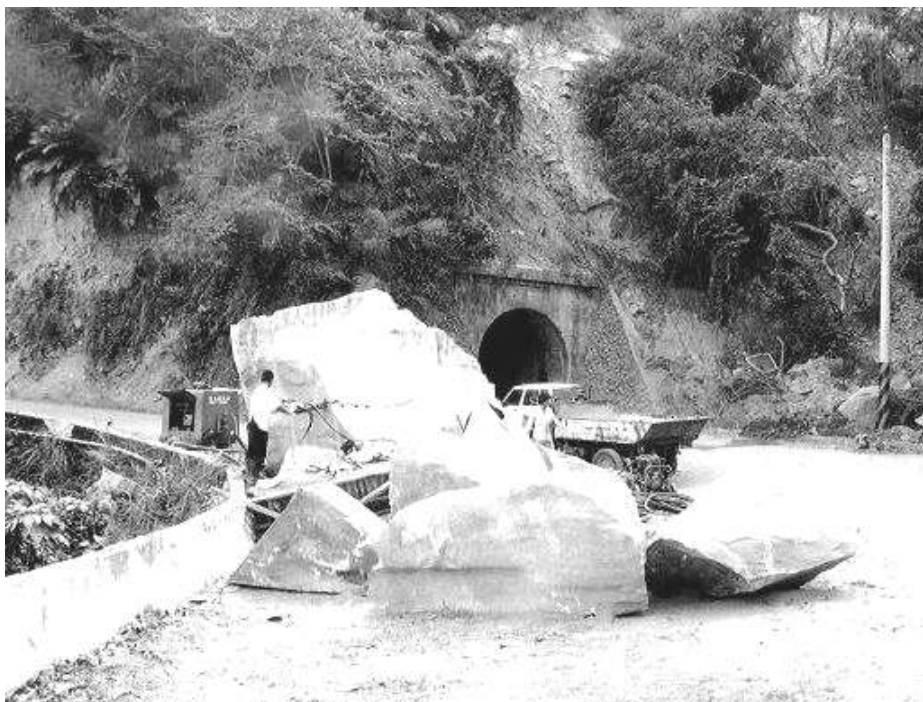
圖 4-58 台八線 34k+650 隧道前巨石坍方清除中
