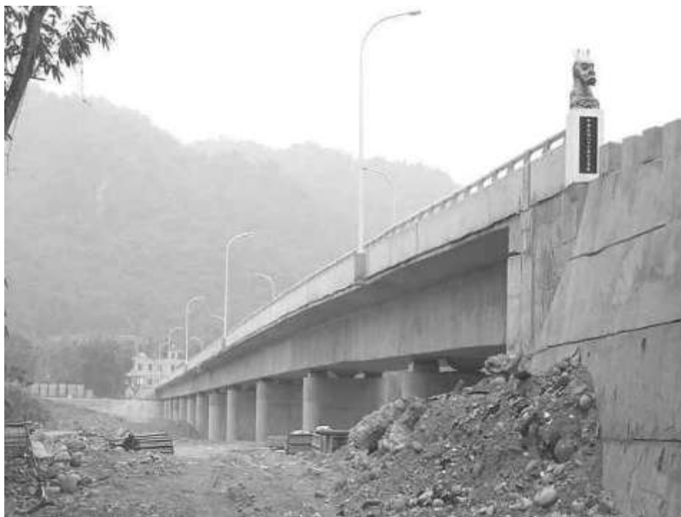
圖 4-100 完工後的龍門大橋
