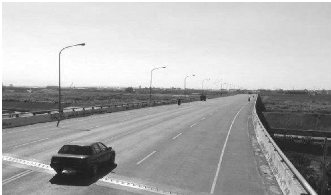
圖 4-79 修復後的新溪南橋
