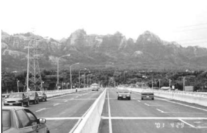
圖 4-88 修復後的炎峰橋
