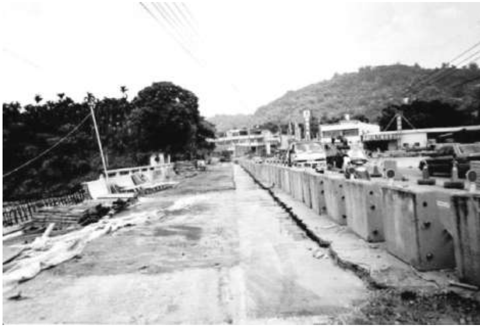
圖 4-84 修復中的延平橋
