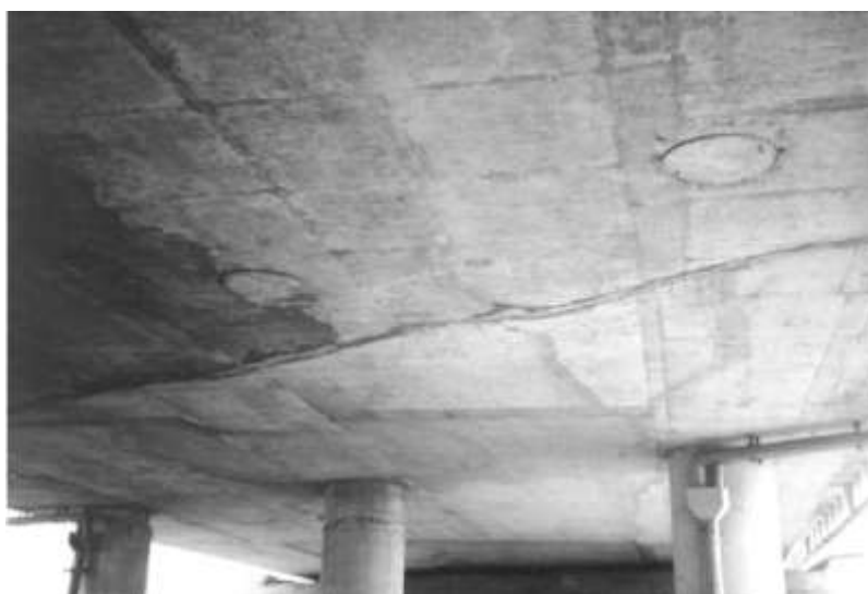
圖 4-78 地震後新溪南橋橋梁裂縫之情形
