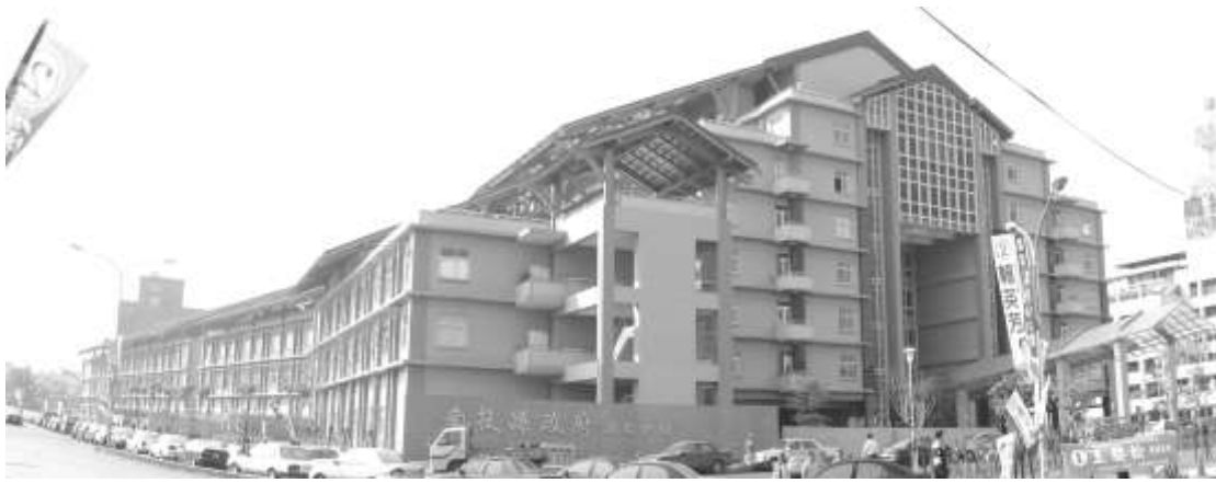
圖 4-14 完工後的南投縣政府大樓
