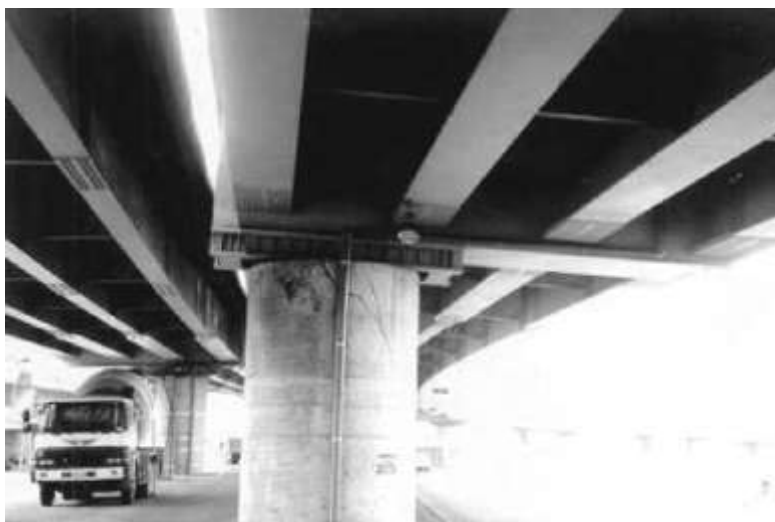
圖 4-89 貓羅溪橋橋墩受損情形
