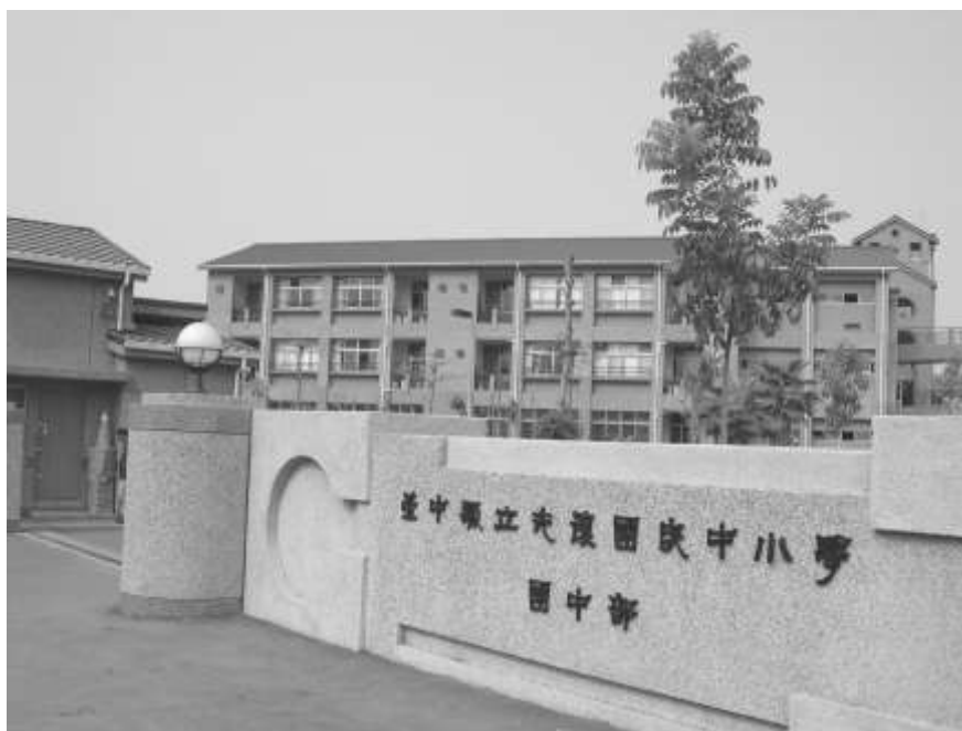
圖 4-30 重建後的台中縣光復國民中小學國中部大門
