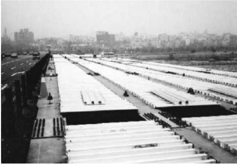
圖 4-74 東勢大橋修復之情形 拍攝日期：民國 90 年 5 月 提供者：國家地震工程研究中心
