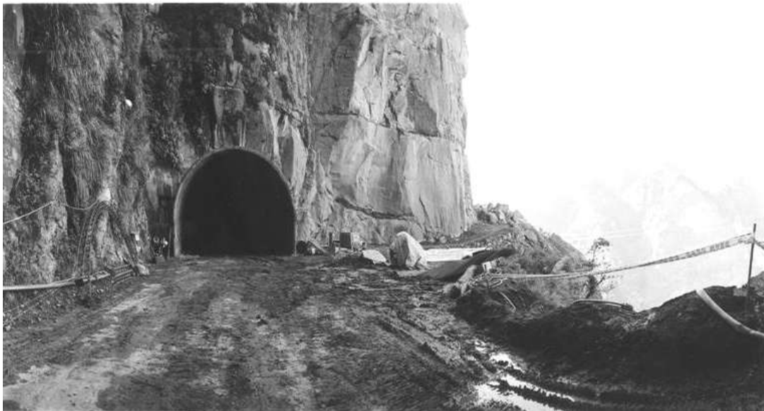
圖 4-56 進行打通中的溪阿公路安定隧道
