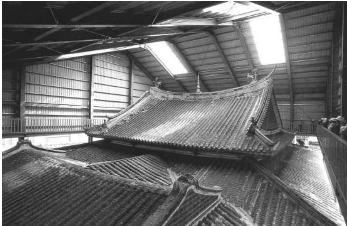
圖 4-108 彰化鹿港龍山寺屋頂掀開情形
