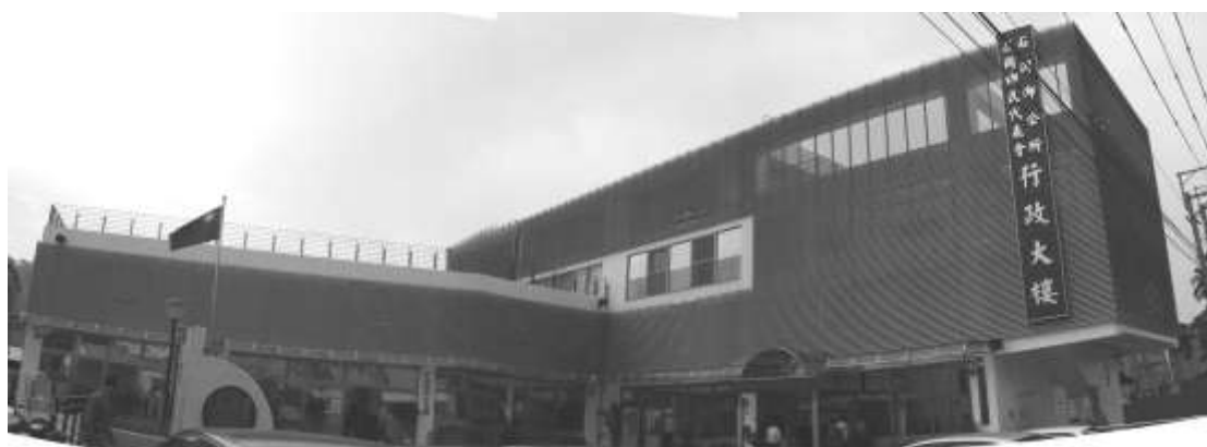
圖 4-9 完工後的石岡鄉公所
