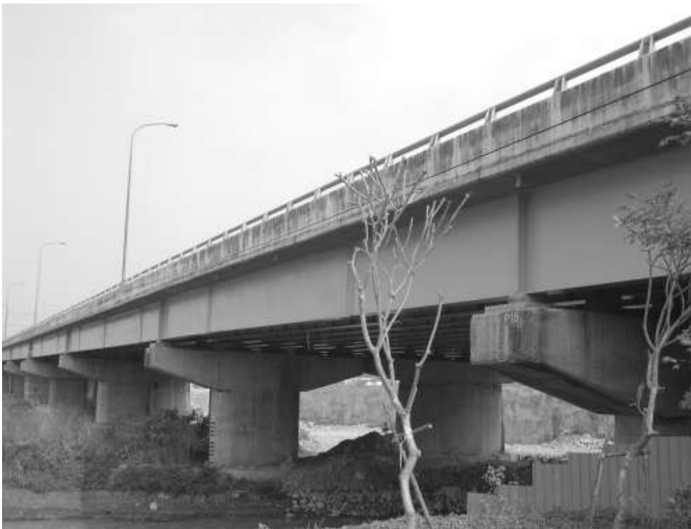
圖 4-82 完工後的烏溪橋 拍攝日期：民國 92 年 12 月 28 日 提供者：黎益肇、陳荻閱
