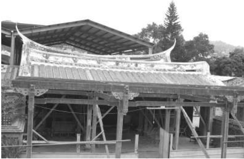
圖 4-105 景薰樓緊急支撐加固情形
