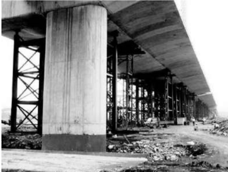
圖 4-91 修復中的集鹿大橋
