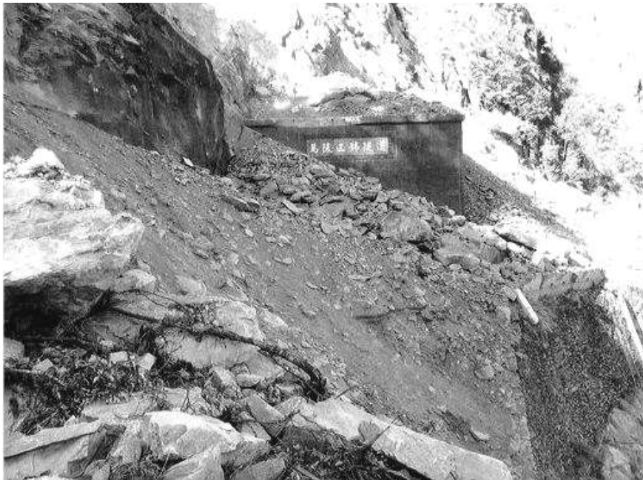
圖 4-63 馬陵三號隧道坍方情形
