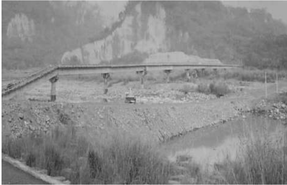
圖 4-98 受損的龍門大橋
