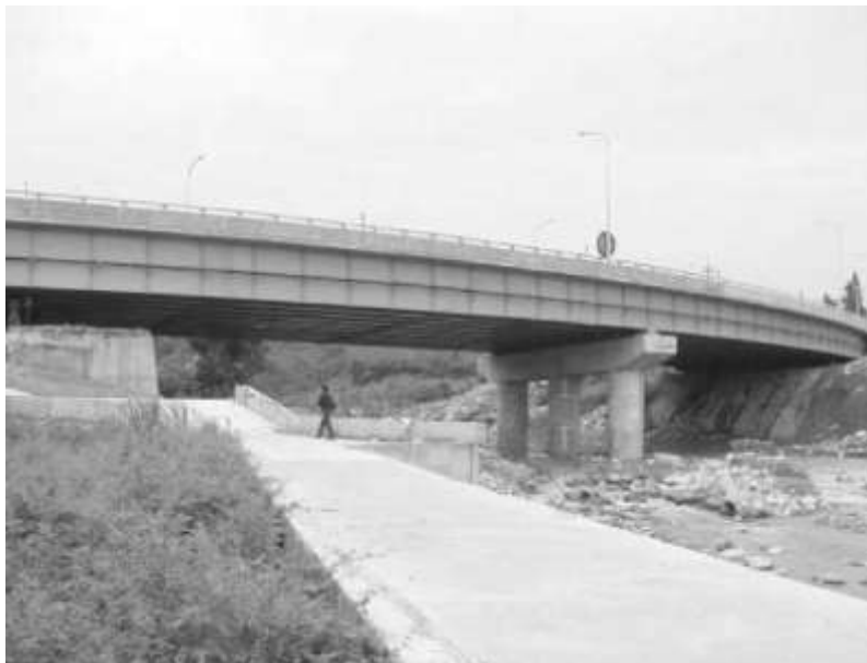
圖 4-68 重建後的石圍橋
