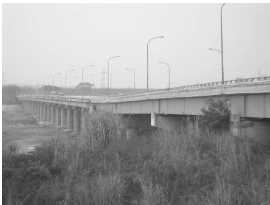
圖 4-94 完成修復的名竹大橋
