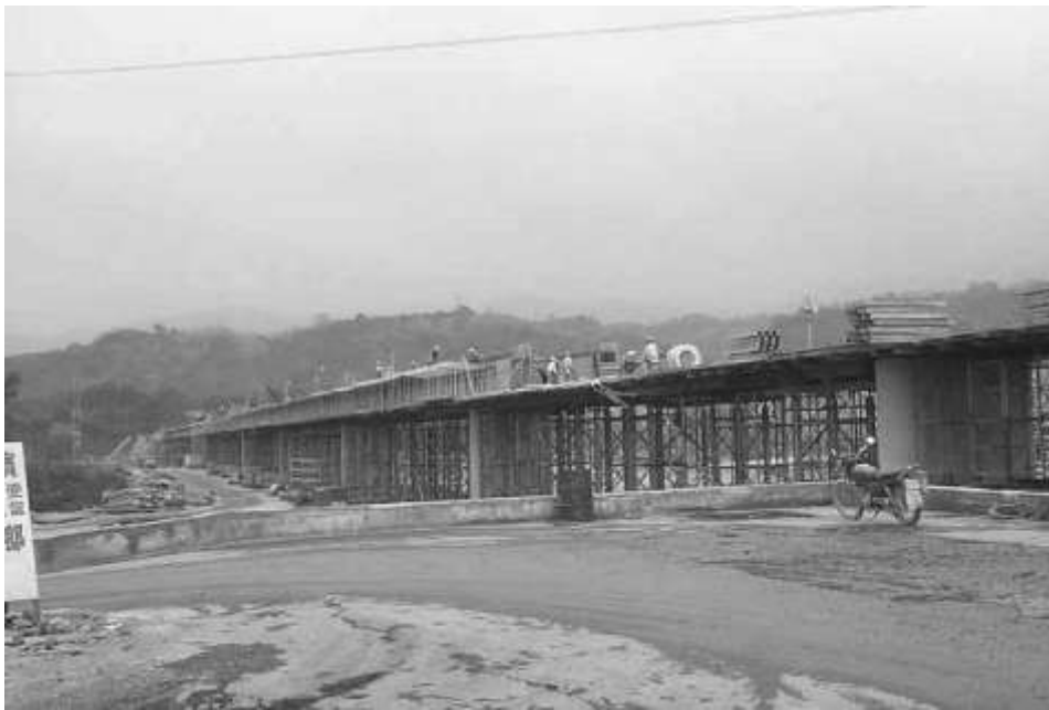
圖 4-96 修復中的鯉魚大橋 拍攝日期：民國 89 年 2 月 提供者：國家地震工程研究中心
