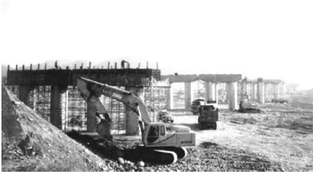
圖 4-81 復建中的烏溪橋 拍攝日期：民國 89 年 8 月 提供者：國家地震工程研究中心
