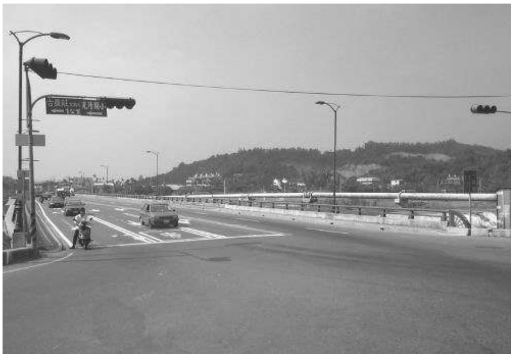
圖 4-77 修復完成的一江橋
