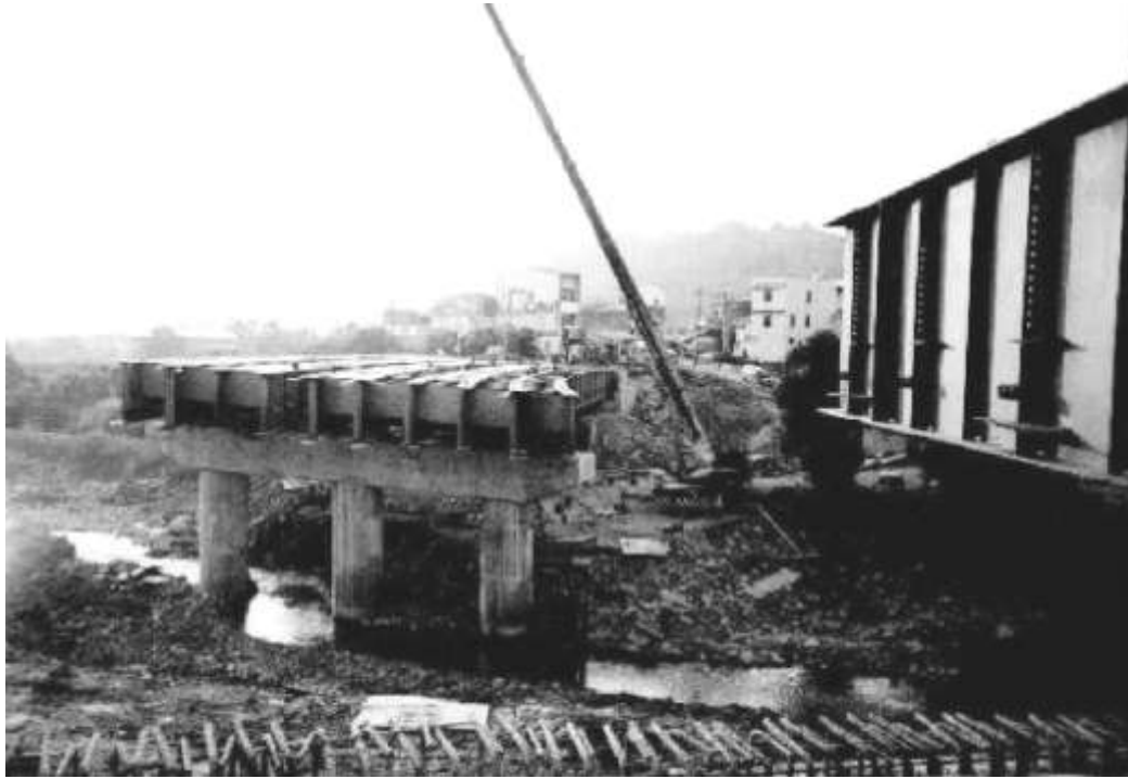
圖 4-67 重建中的石圍橋
