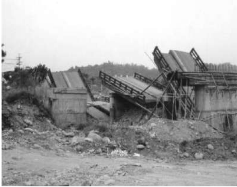
圖 4-76 震後損毀的一江橋
