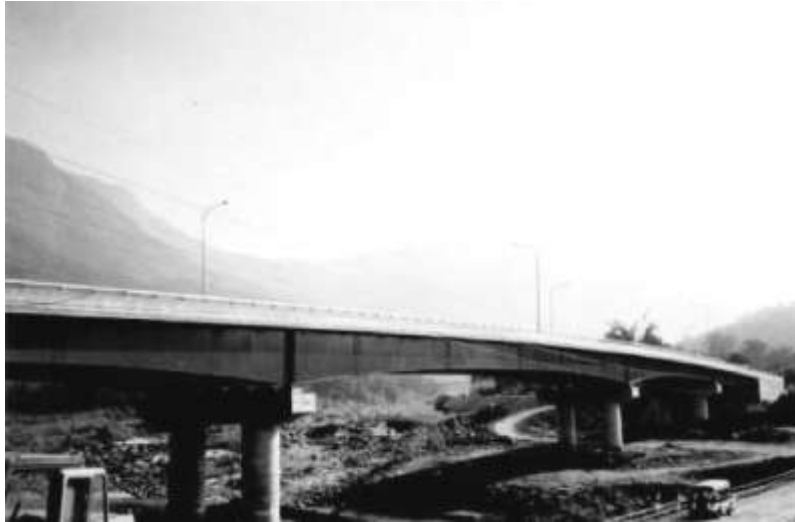
圖 4-103 完工後之桶頭橋
