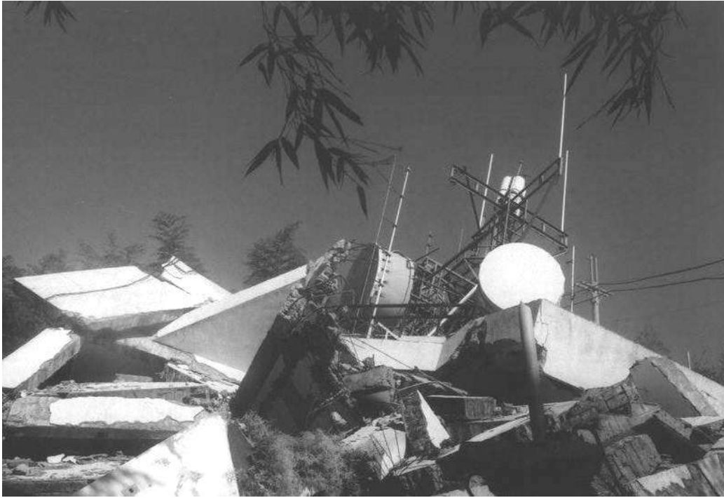
圖 4-10 倒塌的集集大山轉播站
