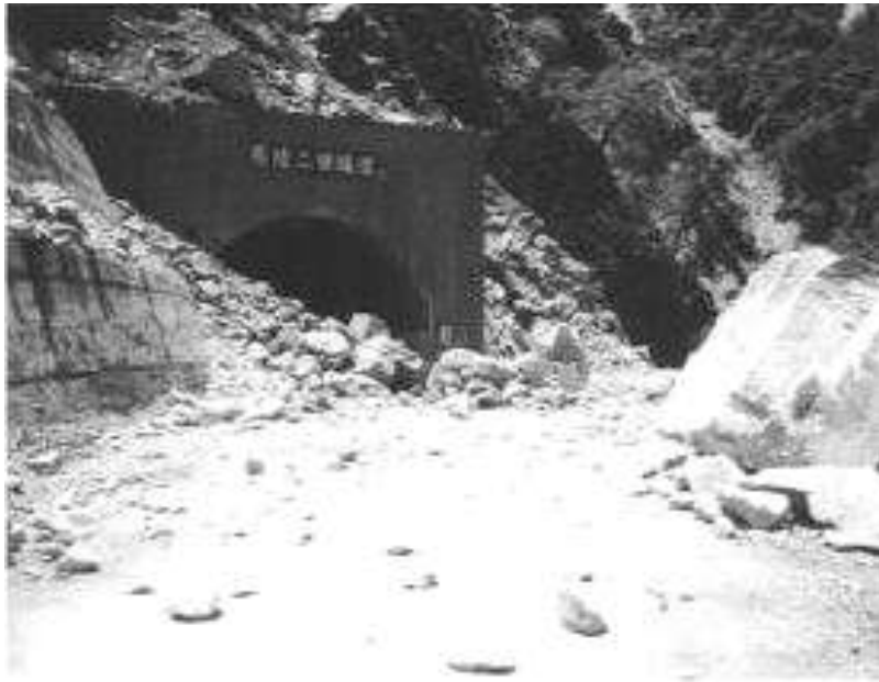
圖 4-62 震災後馬陵二號隧道坍塌之情形
