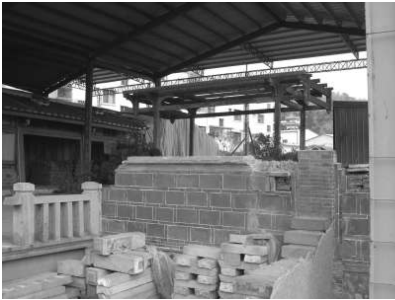
圖 4-106 景薰樓中落清理後保護鋼棚架現況
