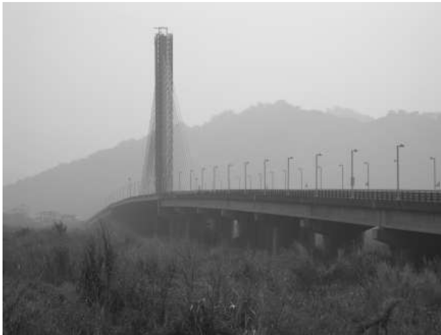
圖 4-92 集鹿大橋現況
