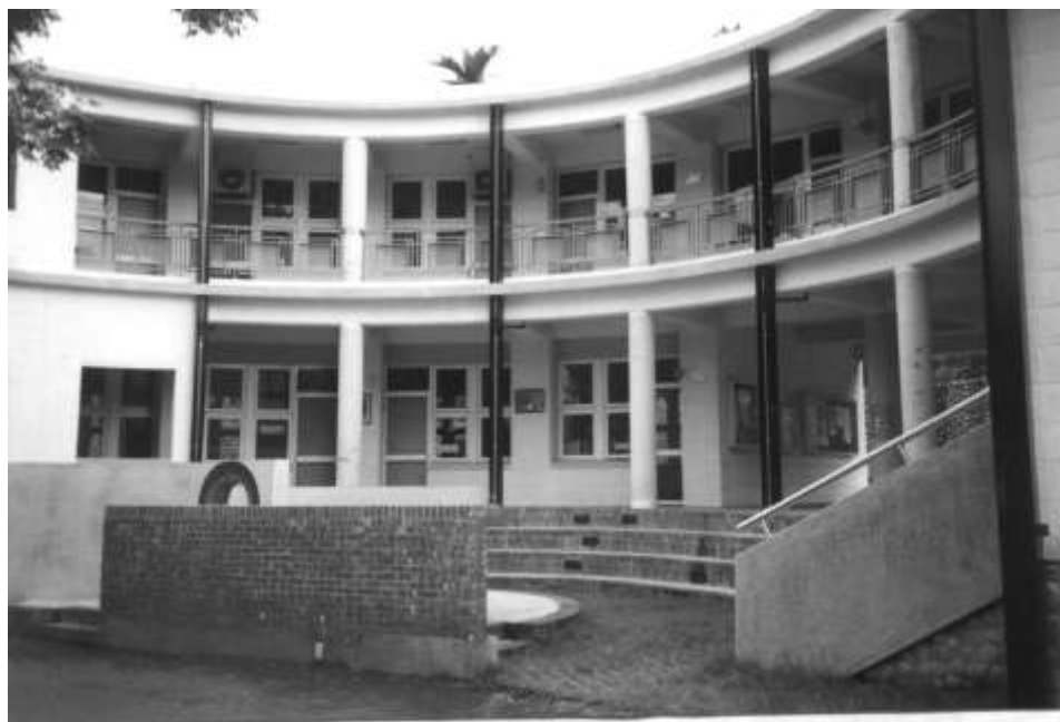
圖 4-36 重建後的中坑國小 拍攝日期：民國 90 年 7 月 30 日
