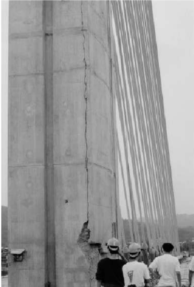
圖 4-90 地震受損的集鹿大橋
