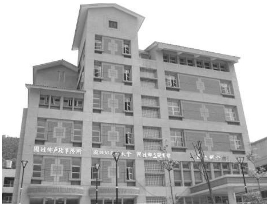
圖 4-18 完工後的南投縣國姓鄉公所
