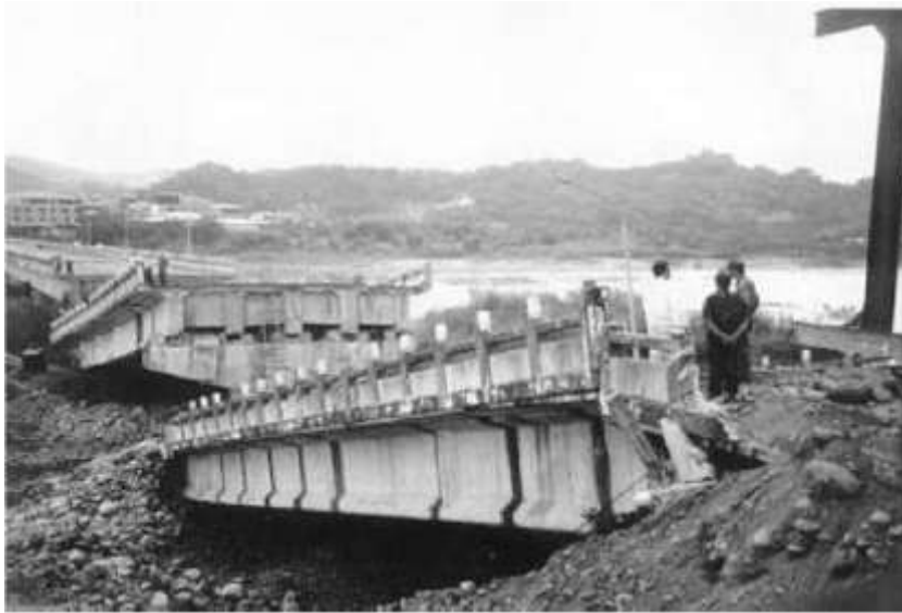
圖 4-69 地震受損的長庚橋
