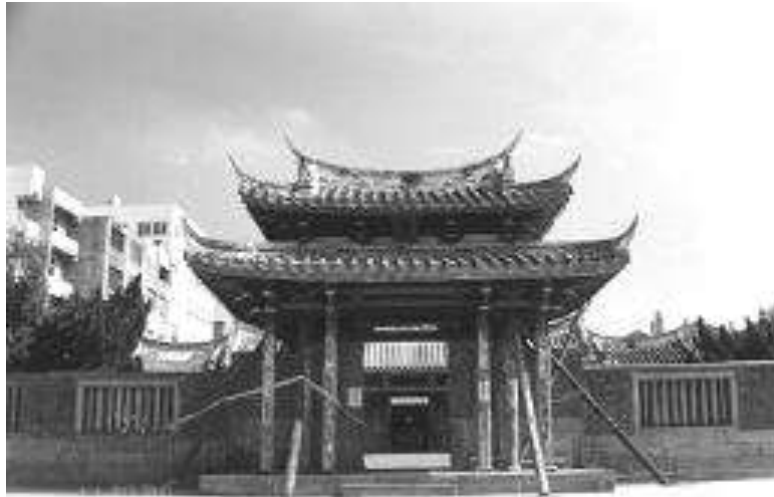
圖 4-107 彰化鹿港龍山寺之支撐加固情形
