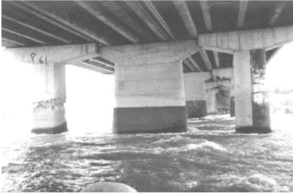
圖 4-72 東勢大橋橋墩受損之情形
