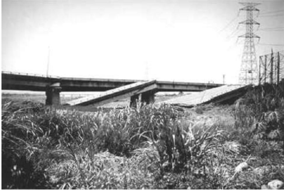
圖 4-80 地震後烏溪橋落橋之情形
