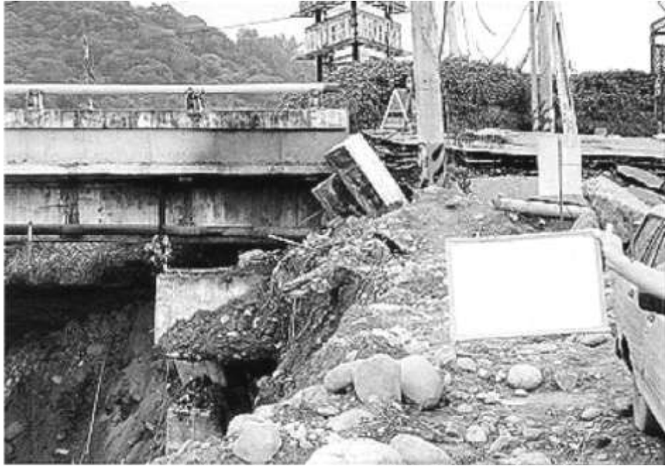
圖 4-83 地震損壞的延平橋橋台 拍攝日期：民國 88 年 9 月 28 日 提供者：國家地震工程研究中心
