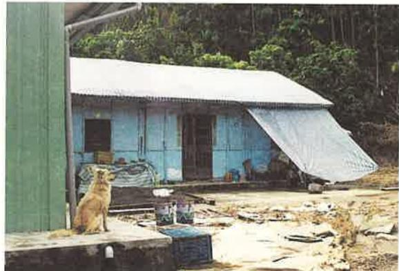
▲羅時安阿公ㄟ舊厝，正身有一些損壞，壁堵採用竹編結構包覆黏土，在地震搖動後看得出早期的工法與先民就地取材的智慧，羅家ㄟ厝頂，仔細地運用布棚包緊覆蓋，自己ㄟ小工免錢，暫時嘛有厝通遮風避雨；而一旁的護龍則由佛教會捐助搭蓋鐵皮，護持了居家的生活空間。
