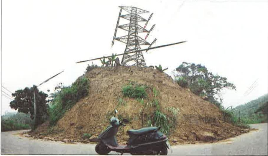
【上圖】雙文路的路面完全斷裂，崩倒的檳榔園上方有一高壓電塔，通往電塔的路，在兩年前就已經斷裂，後來所修的臨時道路，在九二一時震毀，兩天的大雨，讓路面佈滿泥漿且開始崩落至山下。另外，距離電塔基座三公尺處，也開始滑落。（復興村 2000.2.21）
