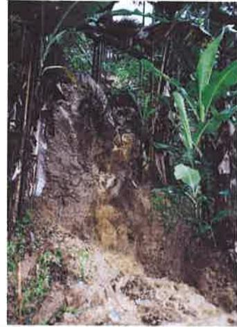
【左圖】原本就崩塌嚴重的福盛村中心產業道路，約在第十五鄰上方的涵箱先前即已堵塞，鄰長黃松水先前已向村長反映，但村長表示鄉公所一直沒有經費處理，六月的豪雨沖刷山壁的土石，水流因無處可去，便直接從上方山壁直穿而下。
