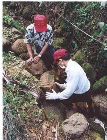
【右二圖】多年未清理，圳道漸漸被石塊、泥土堵塞，而要將掉落的石塊砌回原樣，這可要兼具體能及智慧的判斷，才能修復水圳的自然原貌。
