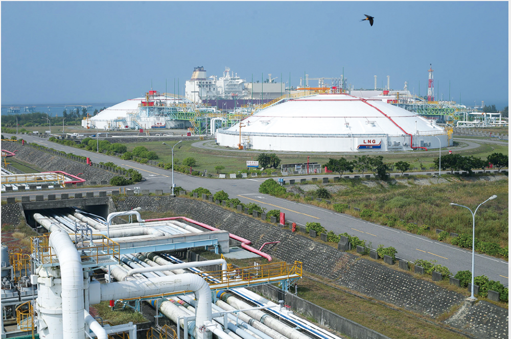
為確保國內天然氣供應穩定，2018 年增訂天然氣安全存量，逐步提高自備儲槽容積及安全存量。圖為永安液化天然氣廠儲槽。（台灣中油提供）
