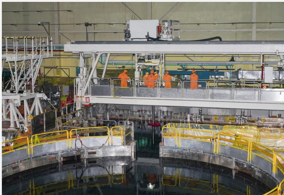
圖15 台電核一廠於10月23日起進行乾貯設施用過核燃料運貯測試【25】
