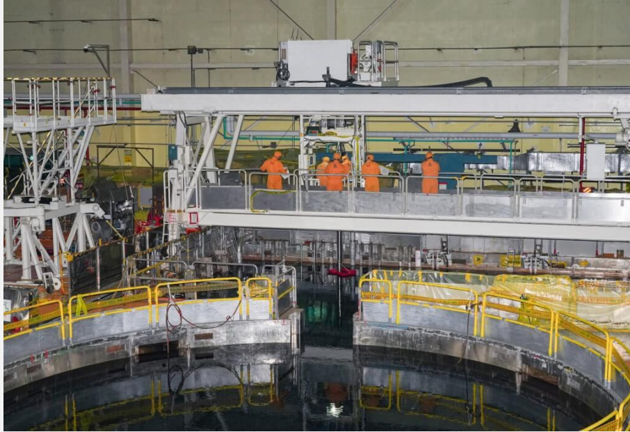
圖14 台電核一廠於10月23日起進行乾貯設施用過核燃料運貯測試【25】
