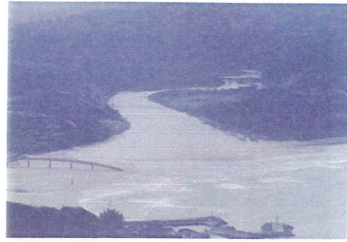
重件碼頭施工後福隆沙灘照片
